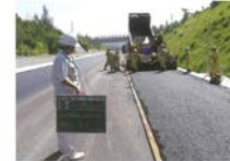
工事施工の立会状況
