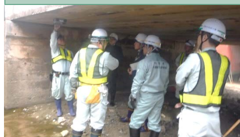
後原橋(国道58号) 緊急対応
