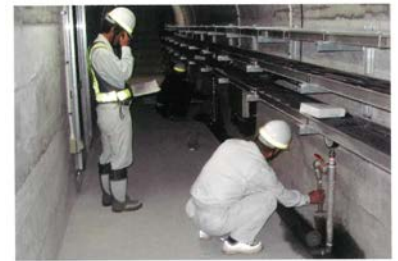
堤体内基礎排水量計測状況
