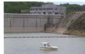
ダム堤体及び貯水池巡視状況
